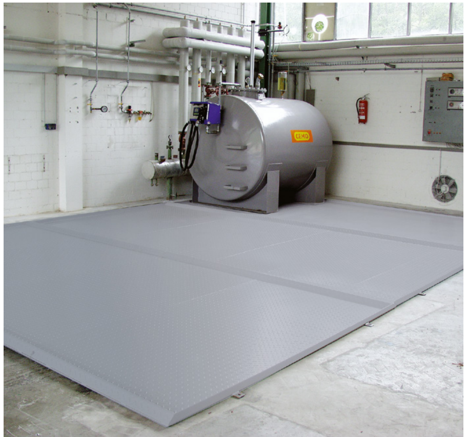
Bild 3: Modularer Abfüllplatz sichert die vorschriftsmäßige Betankung und hält auslaufenden Kraftstoff zurück
